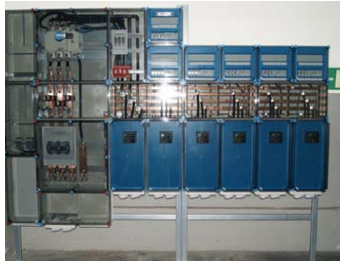
Beispiele: Isolierstoff-Verteiler bis 560 kVA mit Messeinrichtung gemäß den Vorgaben des VNB
